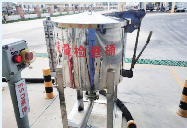
图3 底部连接收油泵的质量检查桶
