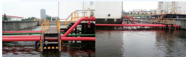
图2 防火堤严密性测试实况
