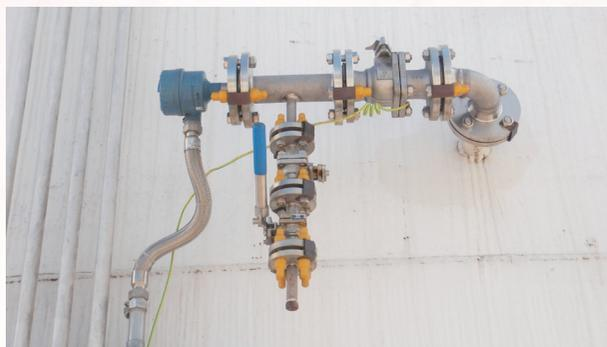
图4 隔断式油罐低液位音叉限位开关报警试验装置实物图
