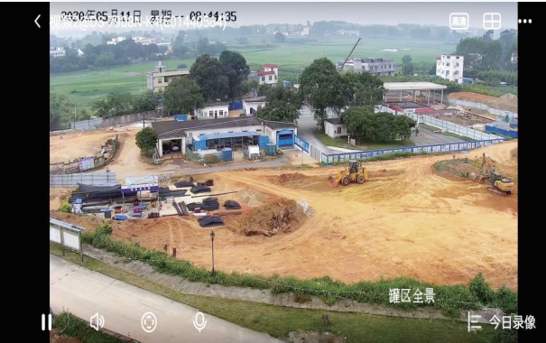
图 5 施工区全景图示
