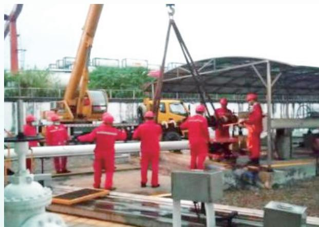
图6 放球方式选择，如现场条件合适，建议从人工改为起重吊机或行吊方式
