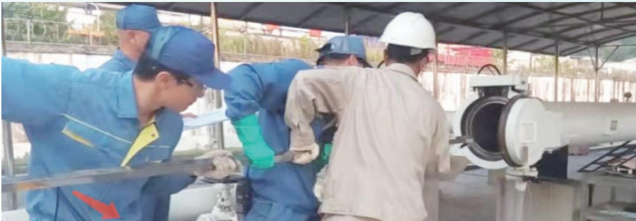
图 4 4 米长的金属杆，用于将检测器顶至发球筒喇叭口
