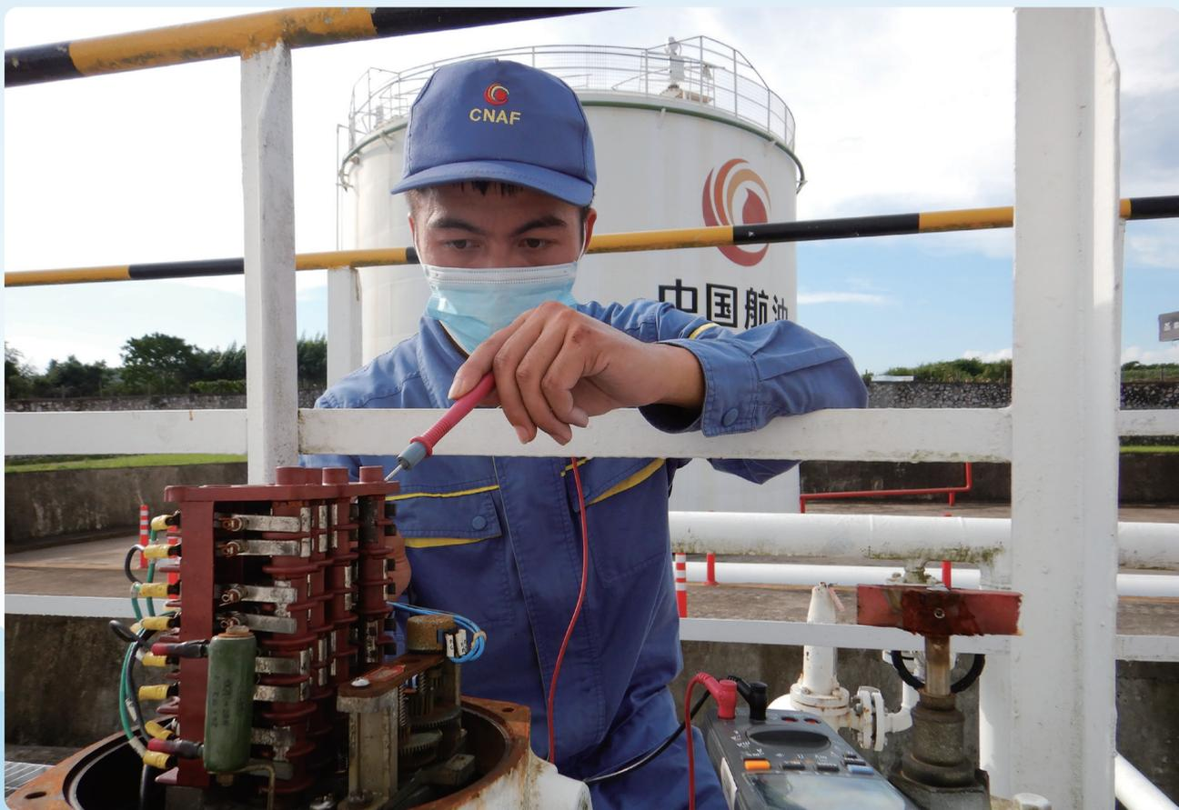
突击队员通过测量触点的通断来分析内部线路
