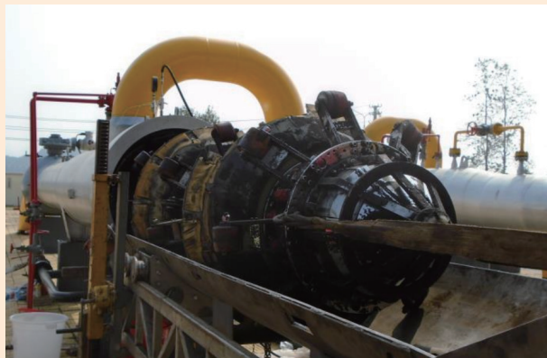
图8 变径检测设备现场应用照片
