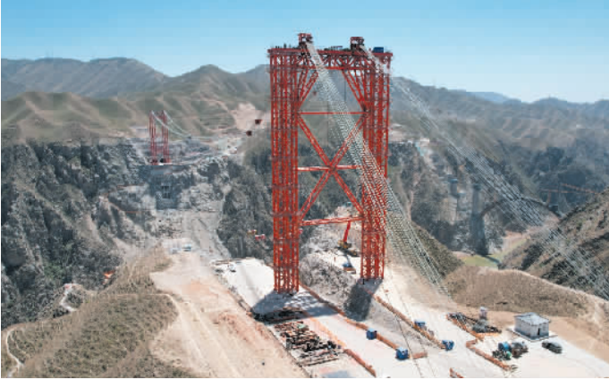
5月10日,由中铁二十局承建的兰(兰州)永(永靖)临(临夏)高速公路关键控制性工程洮河大桥500吨大型缆索吊装系统试吊成功,标志着这一横跨洮河的上承式钢管混凝土拱桥正式进入主体结构施工阶段。图为兰永临高速公路洮河大桥缆索吊装系统。新华社记者陈斌 摄
