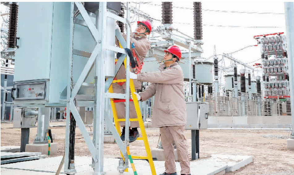
天津送变电工程有限公司日前在1000千伏天津南变电站主变压器扩建工程项目现场,检查站内新装的110千伏断路器。技术人员新装一台300千伏安主变压器及相关设备,投产后可进一步提高我市电网外受电能力。图为运维班组正在对设备进行检查。 沈岳 摄
