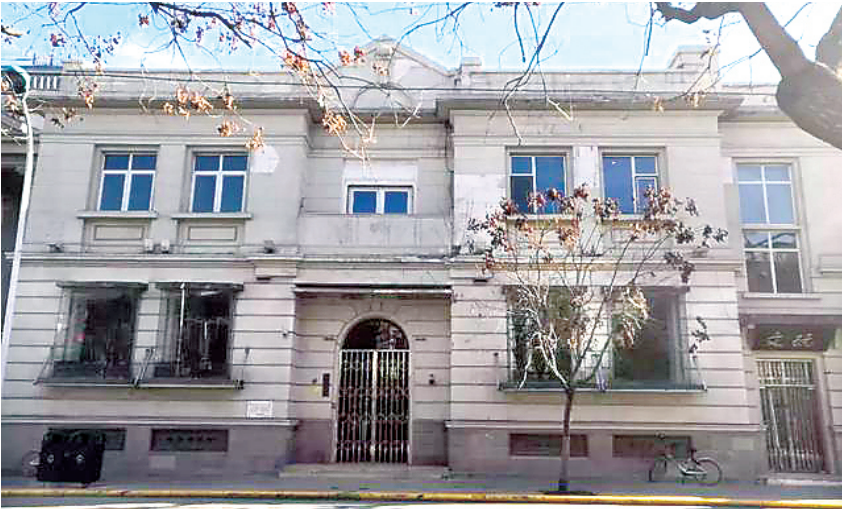
济安自来水公司旧址
