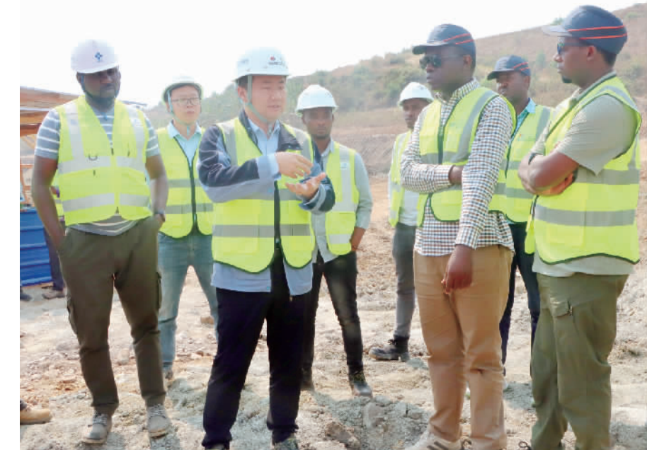
马东明(左三)陪同非洲开发银行和业主代表考察卢旺达姆乌巴大坝项目施工现场。王棋辉 摄
