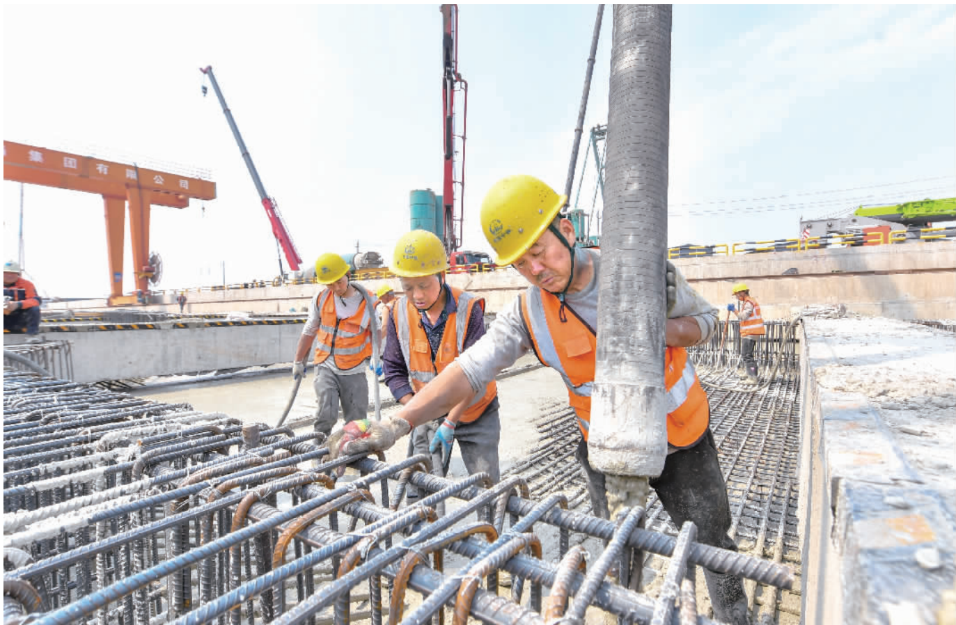
国祥西道站主体结构封顶
