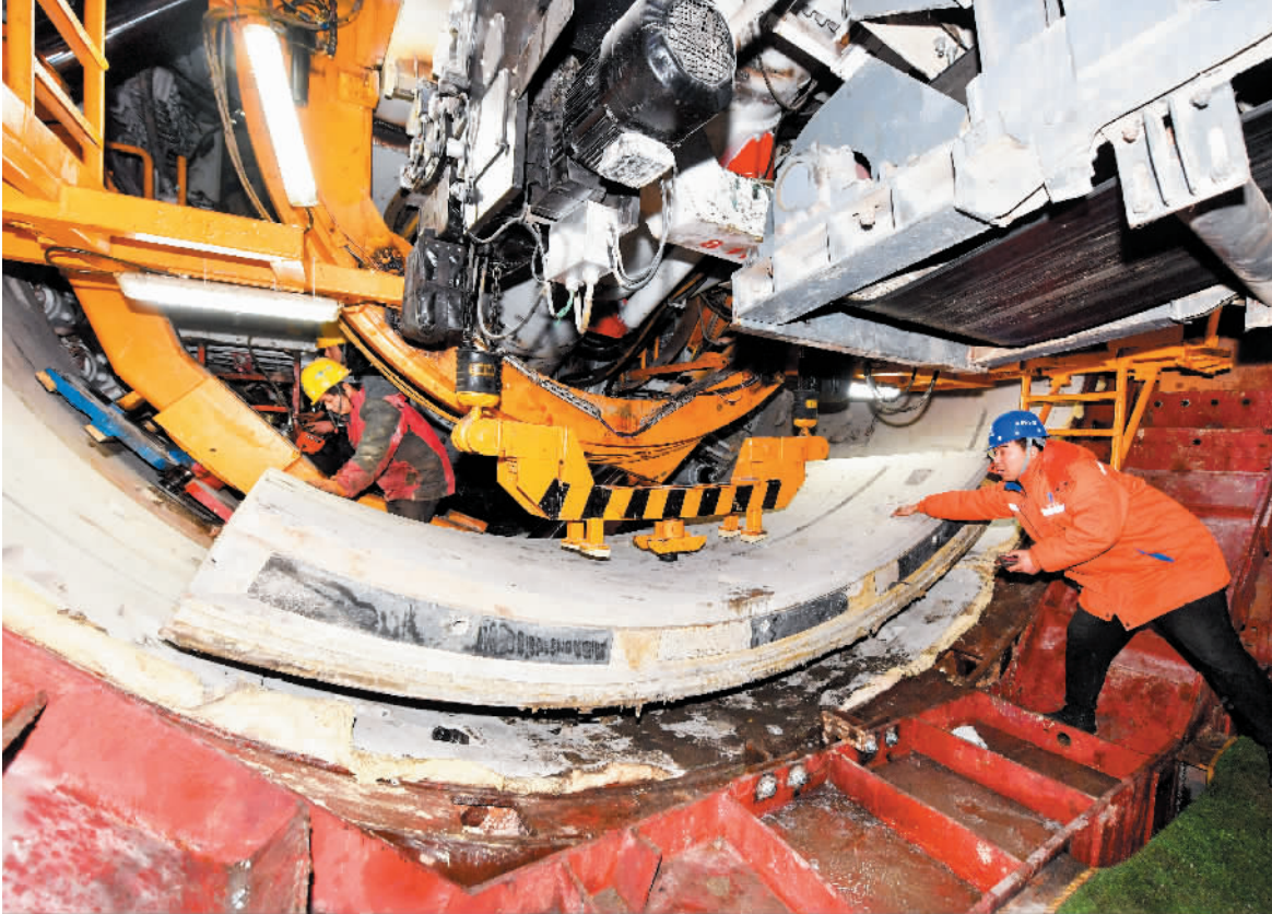
轨道交通建设提速 日前,由中铁十局承建的天津滨海轨道交通B1线国祥西道站至滨海西站区间右线首台盾构机“开拓号”顺利始发,标志着项目全面转入盾构施工阶段,我市轨道交通建设按下新年“加速键”。 张磊 摄
