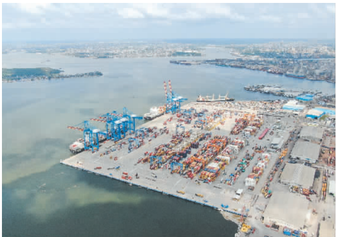
由中国港湾工程有限责任公司承建的阿比让港口扩建项目于2015年启动建设,2020年竣工并正式投入使用。图为1月11日航拍的科特迪瓦阿比让港口扩建项目码头。
