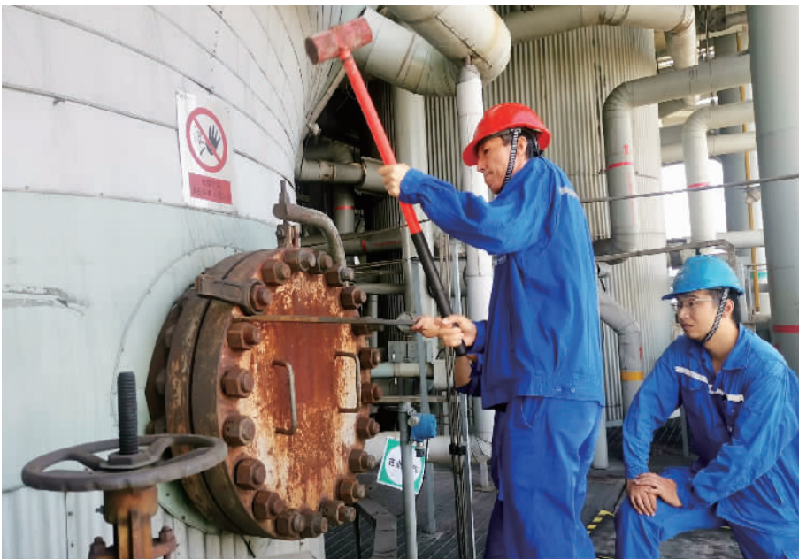
周广利(左)带领员工检修供电设备
