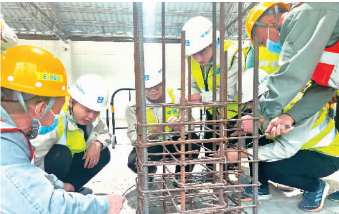
日前，中建一局华北公司安邦项目开展质量安全专项培训，提升全员安全生产意识。图为职工进行钢筋绑扎标准操作培训。 张磊/摄
