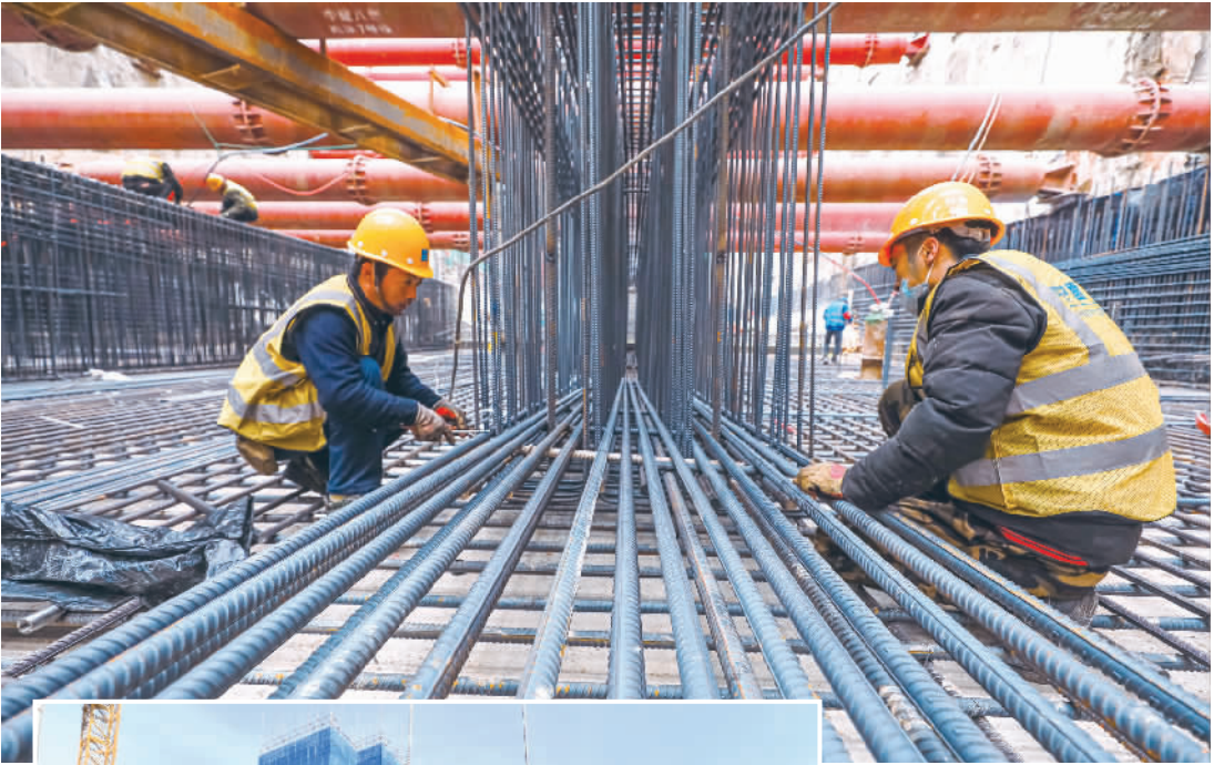
▲连日来，在地铁7号线一期工程六里台站的施工现场，工人们抓紧施工，为全站顺利完工奠定基础。图为职工正在绑钢筋。 沈岳/摄
