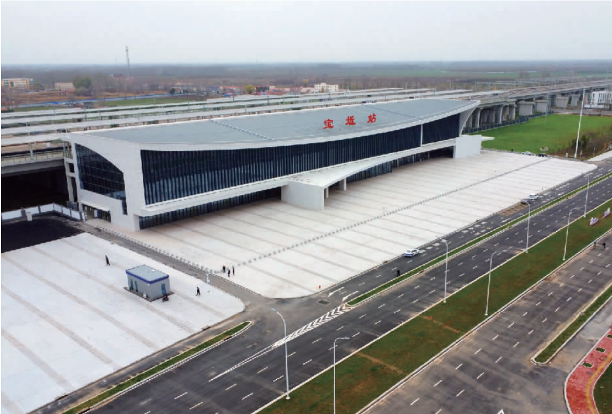
宝坻站正式亮相 日前，随着京唐、京滨城际铁路开始全线运行试验，作为两条高铁线路交汇点的宝坻站近日正式亮相。图为宝坻站全景。张磊摄
