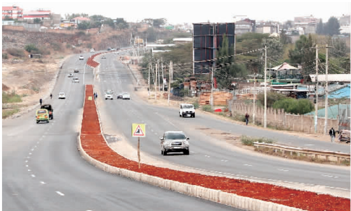
由中国交通建设股份有限公司承建的肯尼亚首都内罗毕东环路拓宽项目7月31日实现全线通车。图为车辆在肯尼亚新内罗毕东环路上行驶。
