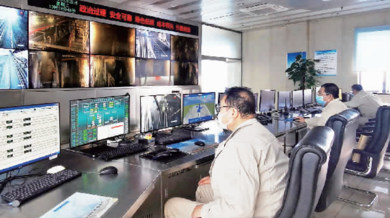
运行人员远程监控斗轮机操作
