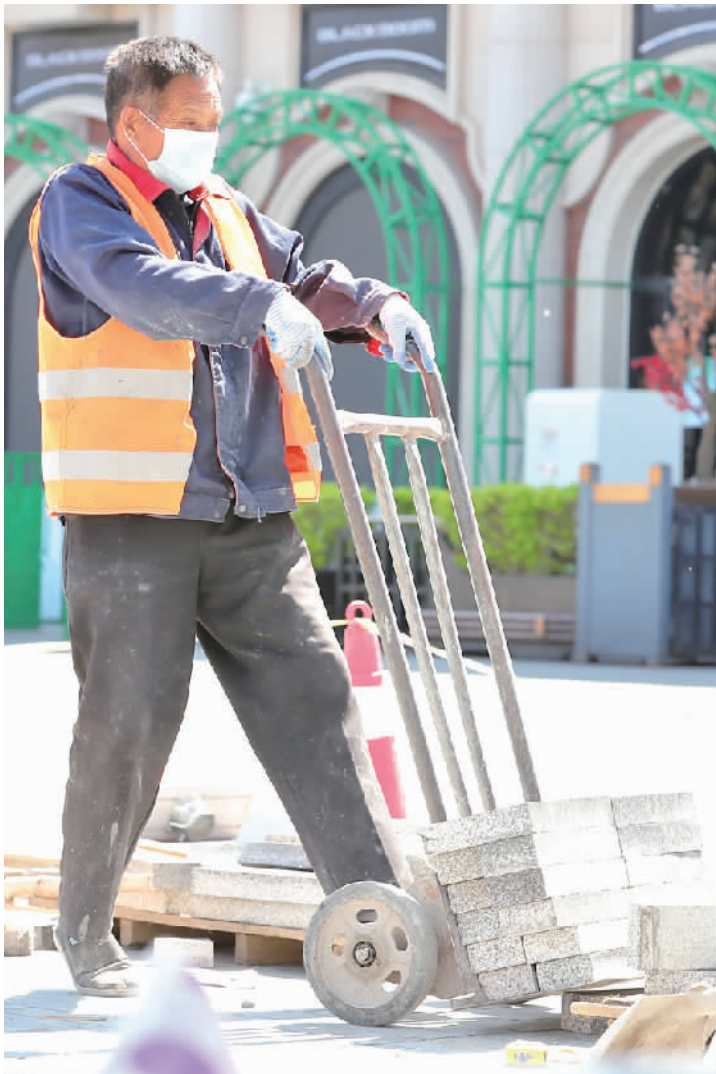
道路维修工人正在维修路面。
