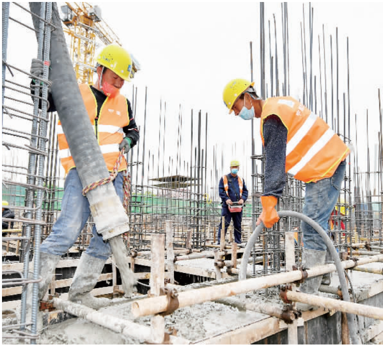
中建三局北京公司天津分公司安居·乐椿轩养老项目工人假期加紧施工。
