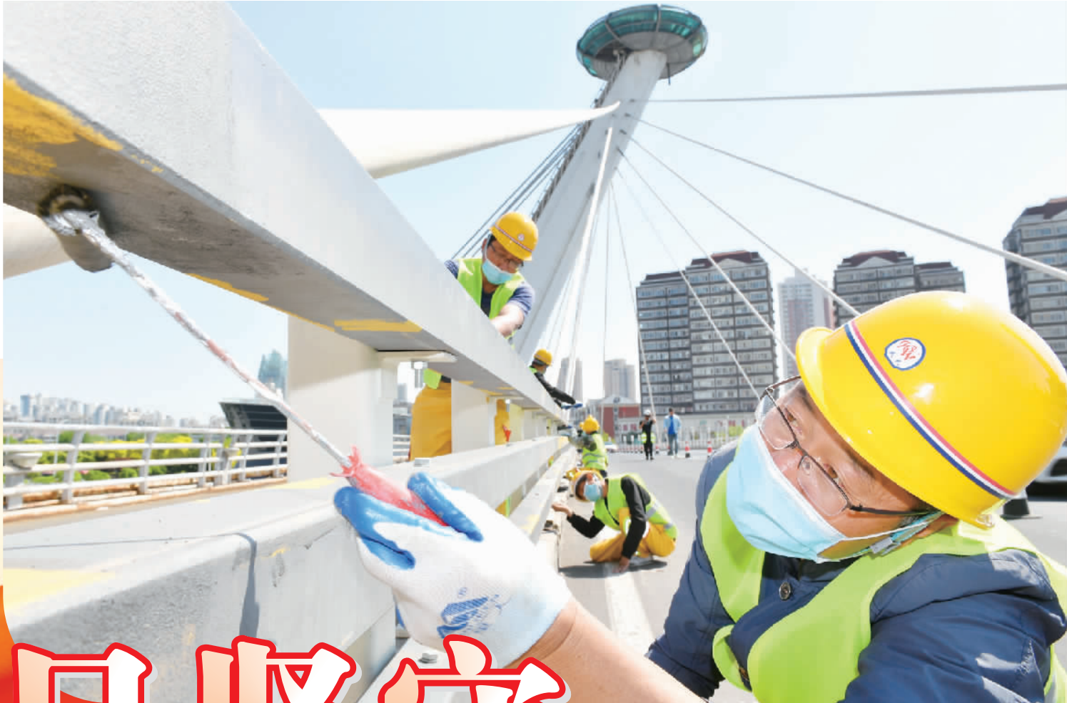
中交一公局第八工程有限公司职工粉刷赤峰桥新更换的防撞护栏，提升改造安全设施。
