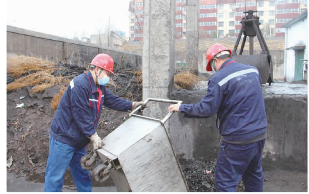
李望波(左一)正在与班组成员清一起清理泵站淤泥
