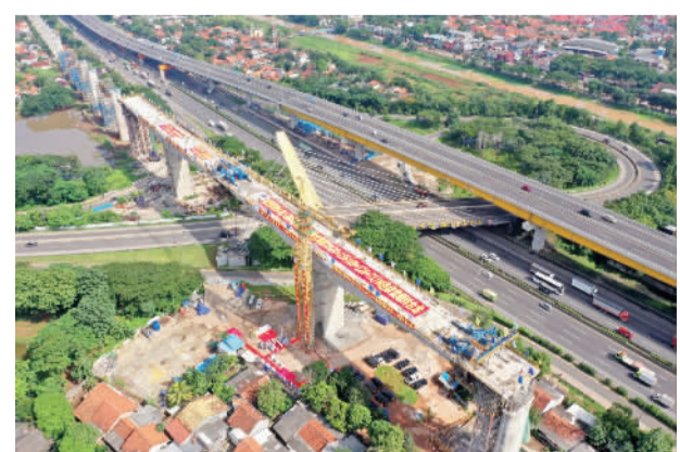
近日,由天津港保税区企业中国铁路设计集团有限公司设计的印度尼西亚雅加达至万隆高速铁路项目,全线最大跨度DK20+156标段连续梁安全精准合龙,标志着雅万高铁建设又一控制性重难点工程取得重大进展。 王昊 张磊/摄
