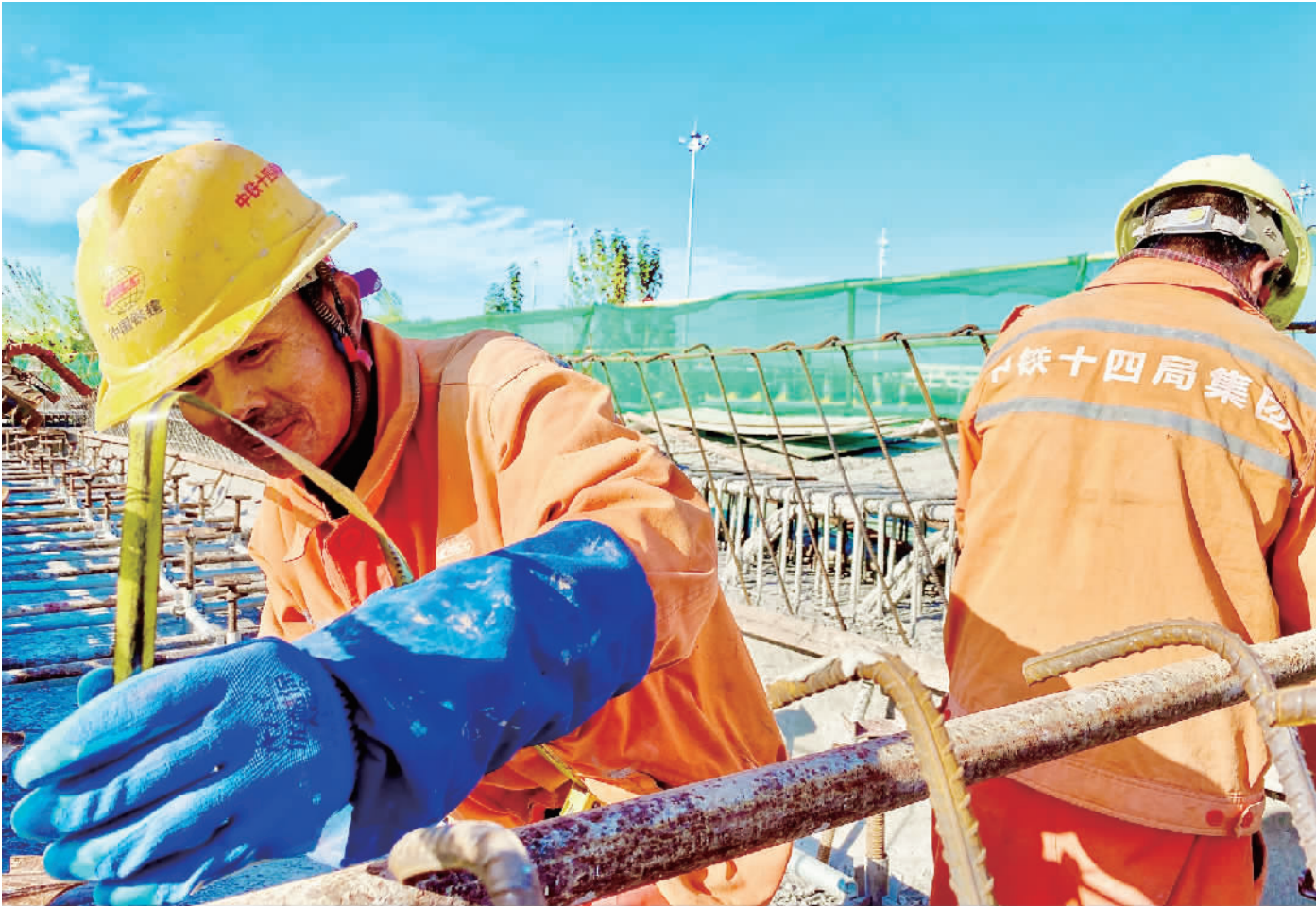
工人正在进行学府中央大道分离式立交匝道桥现浇梁腹板钢筋间距校核 赵璐/摄
