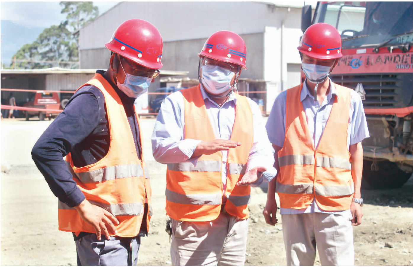
杨旭武(中)在施工现场安排工作
