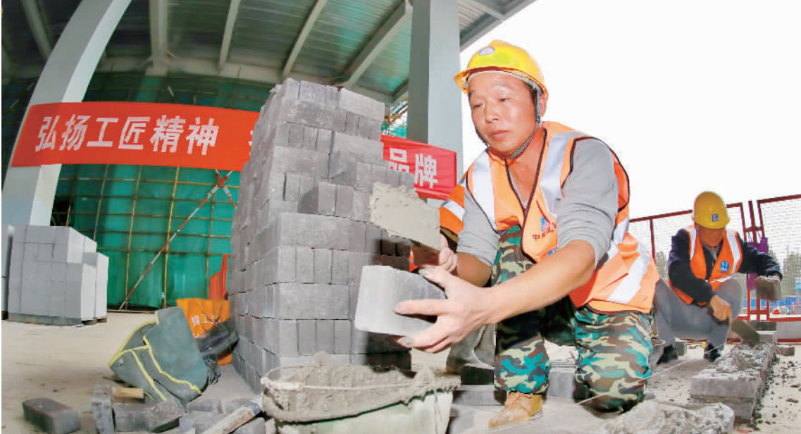
昨天,中建三局华北公司大通关项目工会、云栖路项目工会等联合开展“防疫情保生产,比贡献”为主题的建筑工人技能大赛。图为工人进行墙体砌筑比赛。
