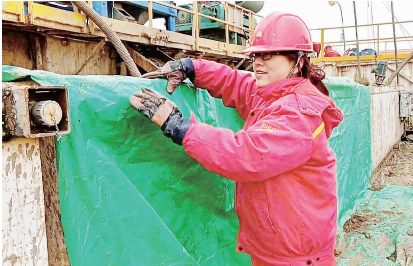
王莉萍用防渗布盖好不落地罐防止泥浆滴落地面 (资料图)
