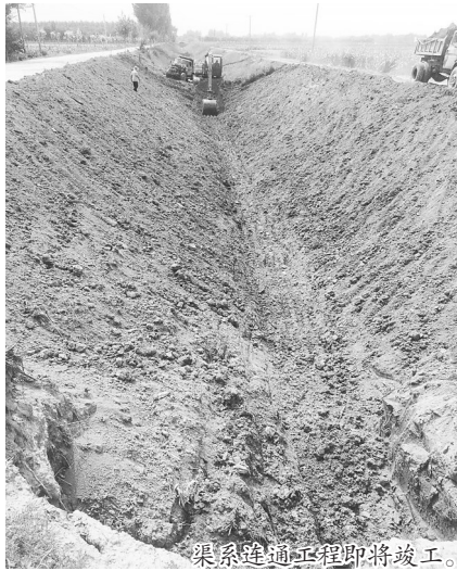
渠系连通工程即将竣工。
