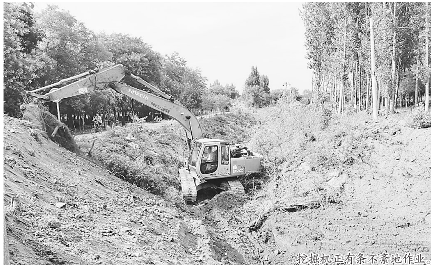
挖掘机正有条不紊地作业。
