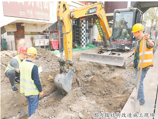
图为报社街改造施工现场。
